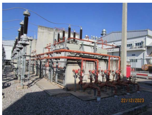
รูปที่ 33 ระบบฟีดพ่นน้ำ
