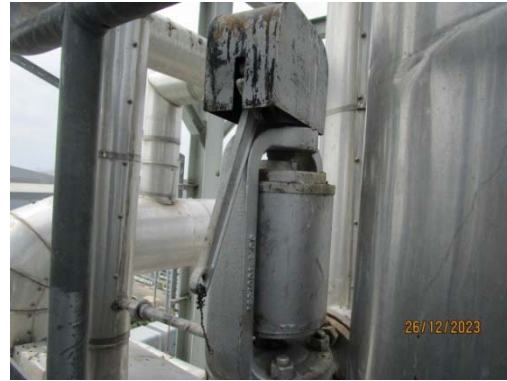
รูปที่ 49 Safety Valve ที่ท่อ steam ของหม้อไอน้ำ
