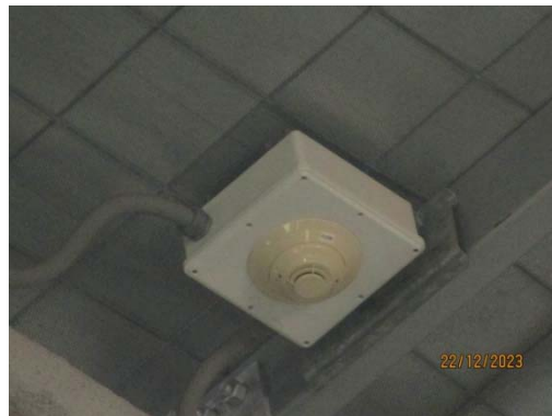
รูปที่ 32 ระบบตรวจจับควัน
